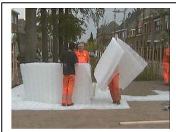
Nachdem der Untergrund vorbereitet wurde, werden die Platten verlegt.
