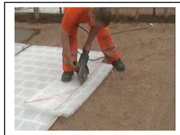
Die Fertigstellung an Kanten oder Aussparungen erfolgt überraschend einfach. Die Platten können mit einem Cuttermesser, einer Schleifscheibe oder einer Dekupiersäge geschnitten werden.
